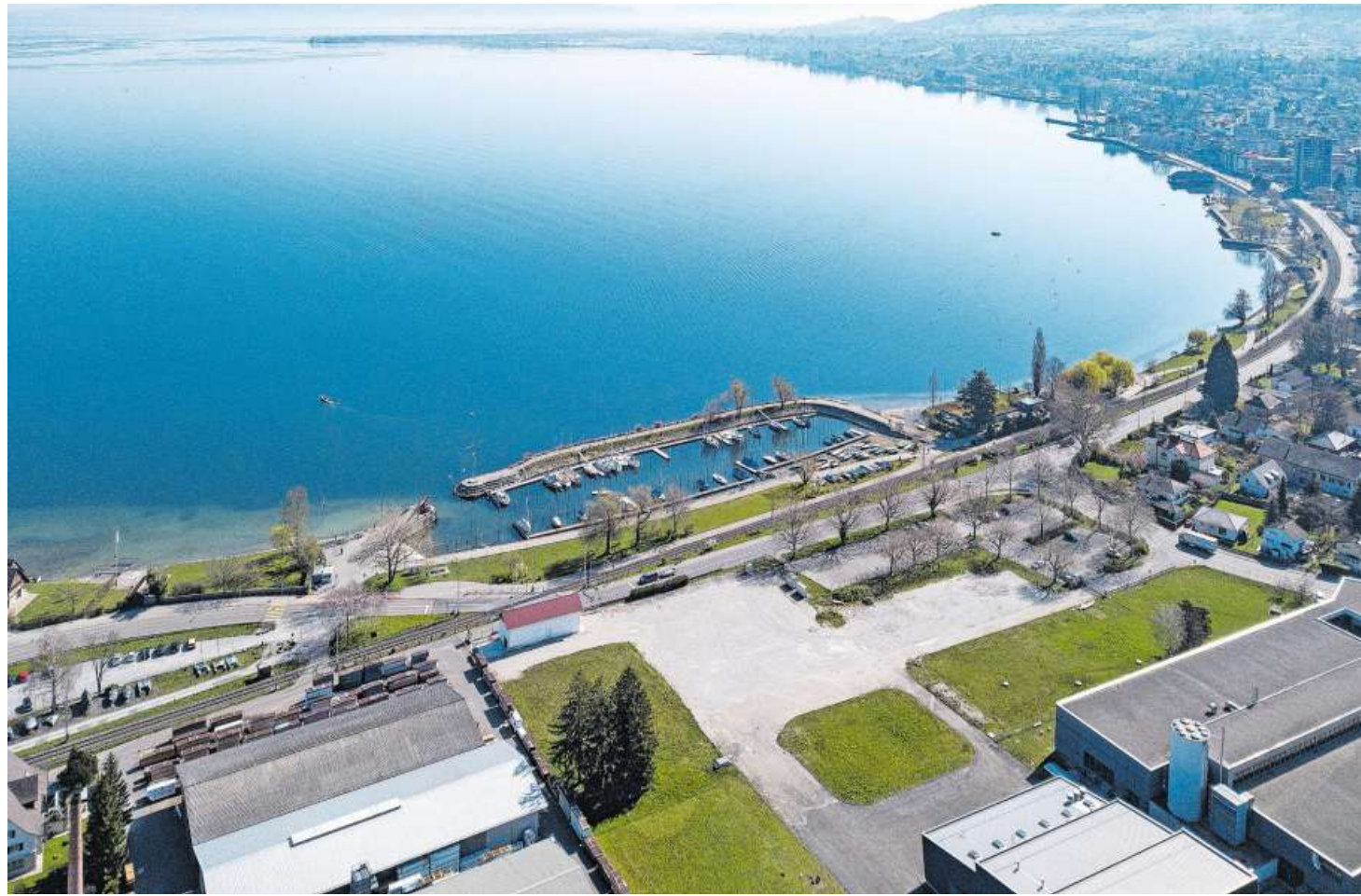
Goldach will den Seezugang mit einer Unter- oder Überführung erleichtern und das Rietli-Areal entwickeln.
